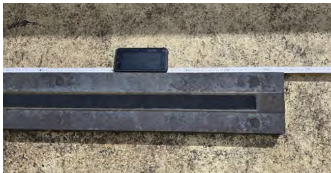
Bild 3: Anodenträger an der Trogwand verschraubt, Trockenlegung 2025
