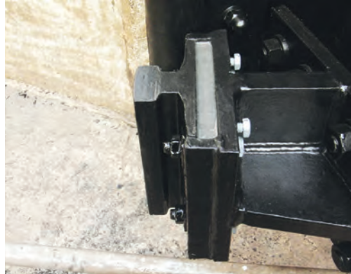
Abbildung 2 Schleuse Kelheim, Stemmknagge vor der Verfüllung
