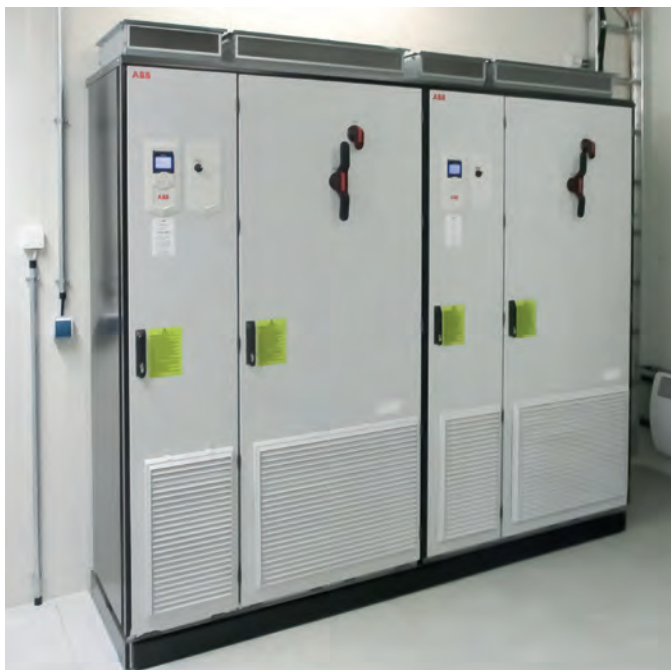
Vier Multidrive-Frequenzumrichtersysteme ACS880 von ABB sorgen für den Gleichlauf der Motoren. (Quelle: ABB)
