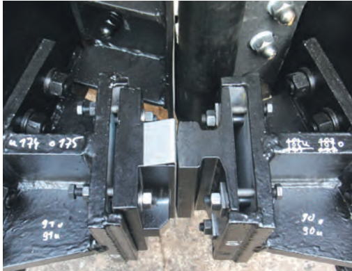
Abbildung 1 Schleuse Kelheim, Stemmknagge nach der Verfüllung
